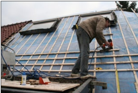
Nagels of schroeven voor bevestiging panlat
